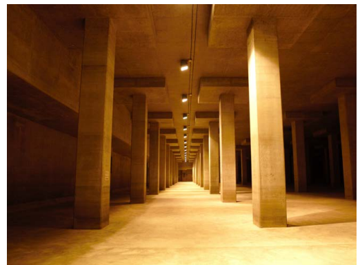
圖 9 大坑東蓄洪池能減輕暴雨期間其下游雨水排放系統的負擔
